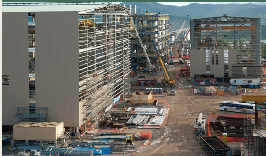
FIGURA 6 CONSTRUCCIÓN DE LA PLANTA DEL PROYECTO PUEBLO VIEJO
